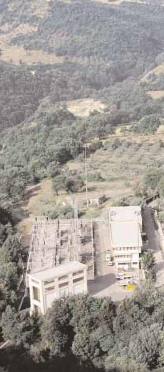
La Centrale idroelettrica di Salisano, sempre nel Lazio, è un impianto ad acqua fluente che utilizza le acque per uso potabile derivate dalle sorgenti del Peschiera e delle Capore.
